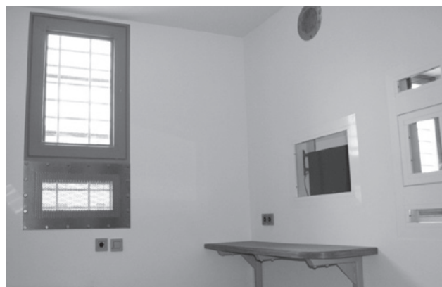
Abb. 3 Fenster, Fernseher und Kommunikationsklappe des PS-Raumes
